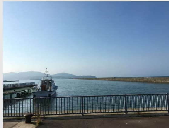
Otaru harbor (Hokkaido) 小樽築港北防波堤 (北海道)
